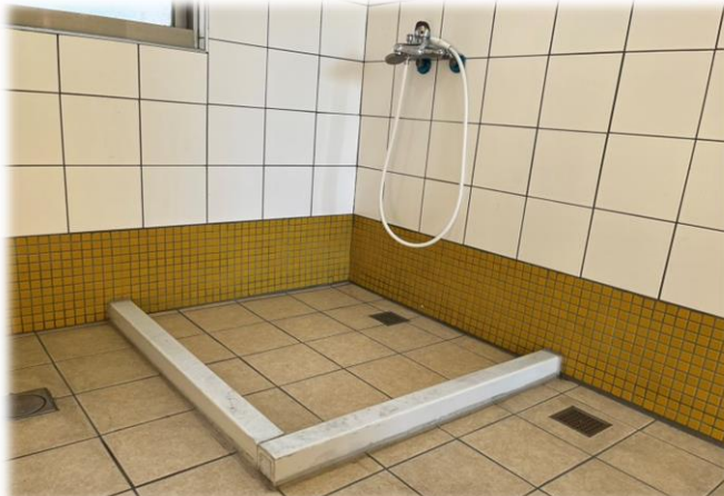
設置熱水淋浴區，以備不時之需
